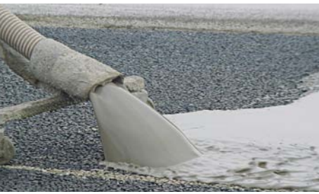
Particolare iniezione della boiaccia
