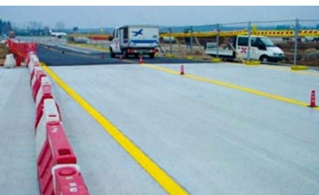
Strada di servizio in Darifalt®
